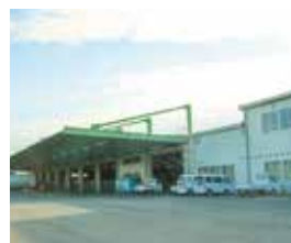
JA紀州の花き・野菜集出荷施設「がいなポート」。低温庫やスターチス専用の冷蔵庫も備わっている。
