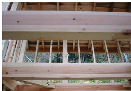
写真2 施工されたスギヒノキ複合積層材
