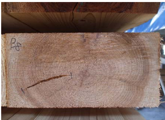
写真1 内部割れ発生のようす
