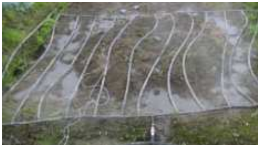
写真1 点滴かん水チューブによる熱水処理
