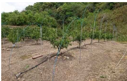
写真2 直管パイプ等設置後の被覆前の様子
