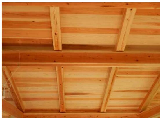
図 1 構造用スギ床パネルの施工写真
