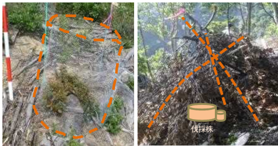
図3 メタルラス施工状況
