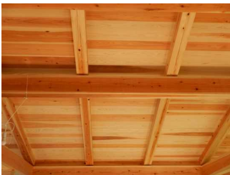
図 1 紀州材構造用床パネルの施工写真
