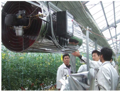
図2 現地試験で使用した CO 2 発生機 (ホーグス製 ダッチジェット P-100) 注) 1時間あたりの CO 2 発生量 13m 3 施用条件: 7:30 ~ 16:30 の間、1 時間に 6 分稼働
