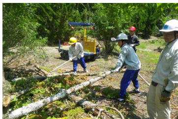
スギ・ヒノキの伐採、搬出作業
