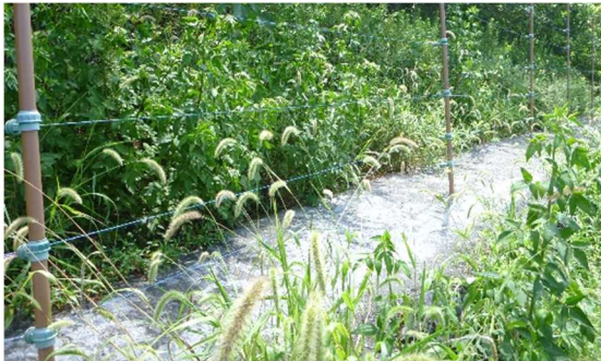
図1 電気柵下の鉄鋼スラグ舗装
