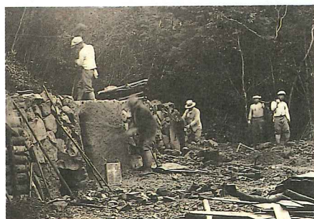
木炭に関する試験 〔築窯作業〕
