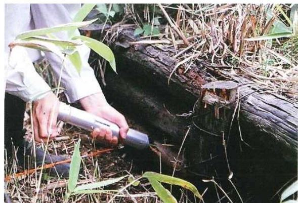
木製構造物の耐久性調査
