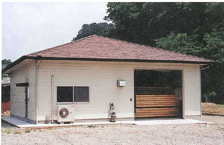
林業センター木材加工棟（平成6年）
