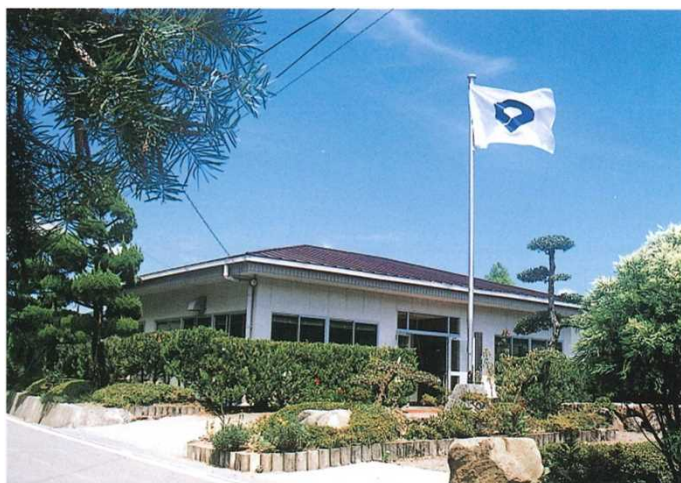
林木育種場新庁舎（昭和54年竣工後） 平成14年から中辺路試験地に改組
