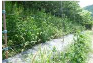
鉄鋼スラグ舗装+電気柵
