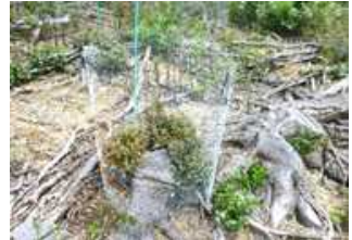
メタルラス設置状況
