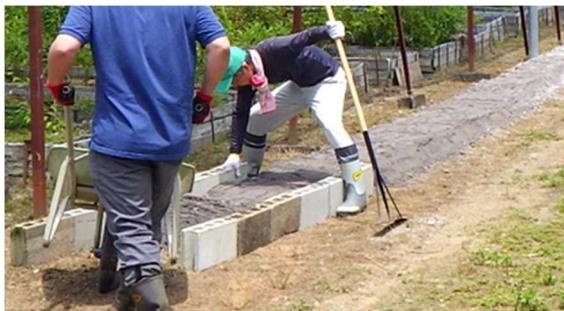
その後、十分に散水しながら、平坦で広い部分はプレートコンパクターをかけ、傾斜部分や狭い部分は土を均すトンボで叩くと施工完了となり、約2週間で硬化します。今回、1m幅で施工したことが影響したのか、散水して柔らかくなった部分ではプレートコンパクターが沈み込んでスラグが飛び散り陥没してしまいました。対策として、徐々に締め固めるよう、散水前、散水途中と複数回プレートコンパクターをかけました。それでも沈み込む場合は、プレートコンパクターにロープを結んで前方から引っ張り上げながらかけると綺麗に施工できました。
