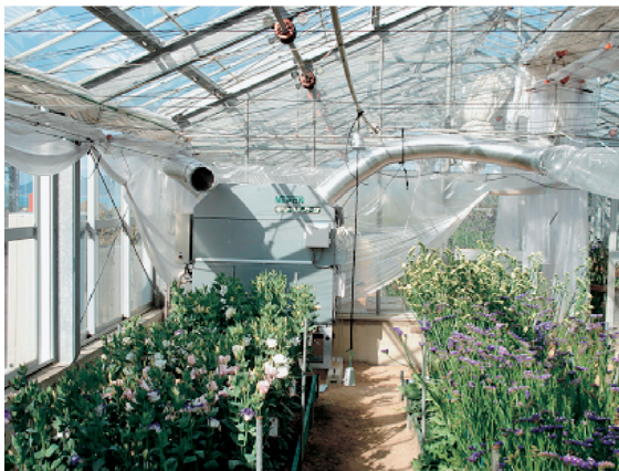
スターチスの夜間冷房
