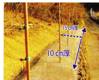
図1 鉄鋼スラグ簡易舗装
