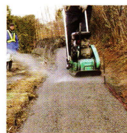
図4 散水と転圧作業
