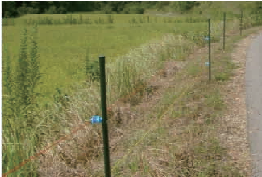
電気柵の設置（御坊市）
