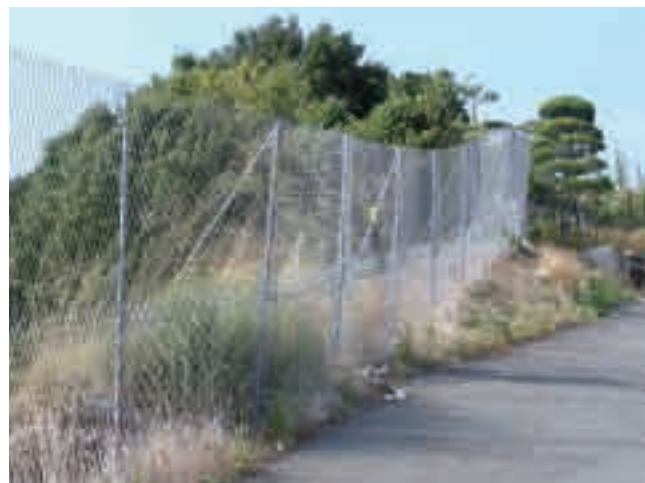
ワイヤーメッシュの設置（みなべ町）
