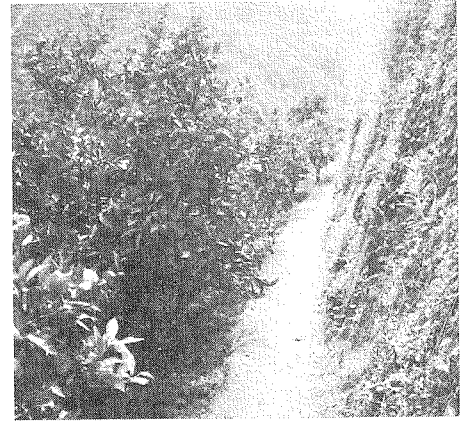
写真10 作業道設置後の状況
