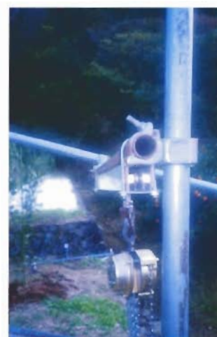
図3 横張柱に利用したハンガーレール
