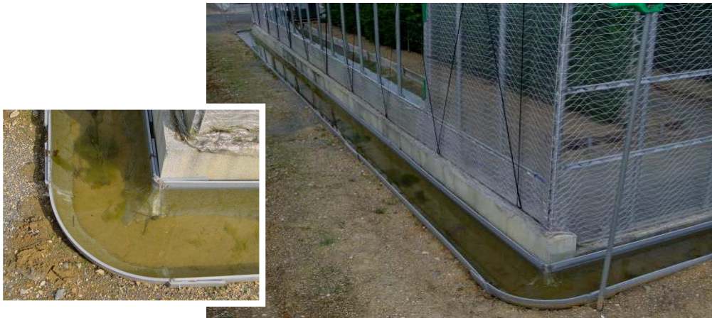
写真1 湛水溝の設置状況
