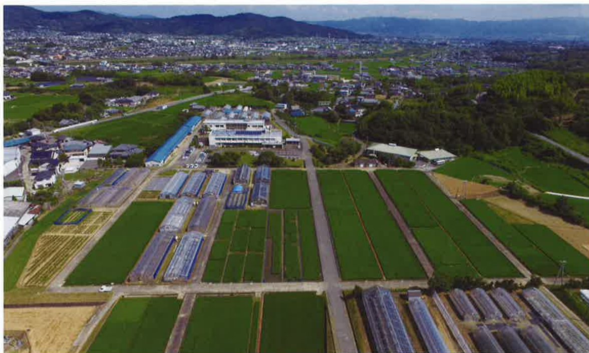
ドローンから望む場全景（平成29年8月2日）
