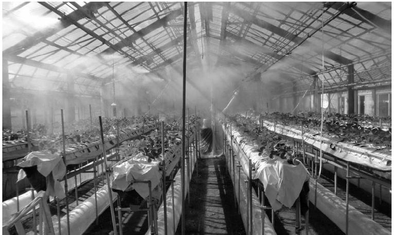
第1図 細霧冷房および送風処理
