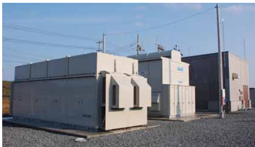
図 1.3.1-5 NAS 電池システムの外観
