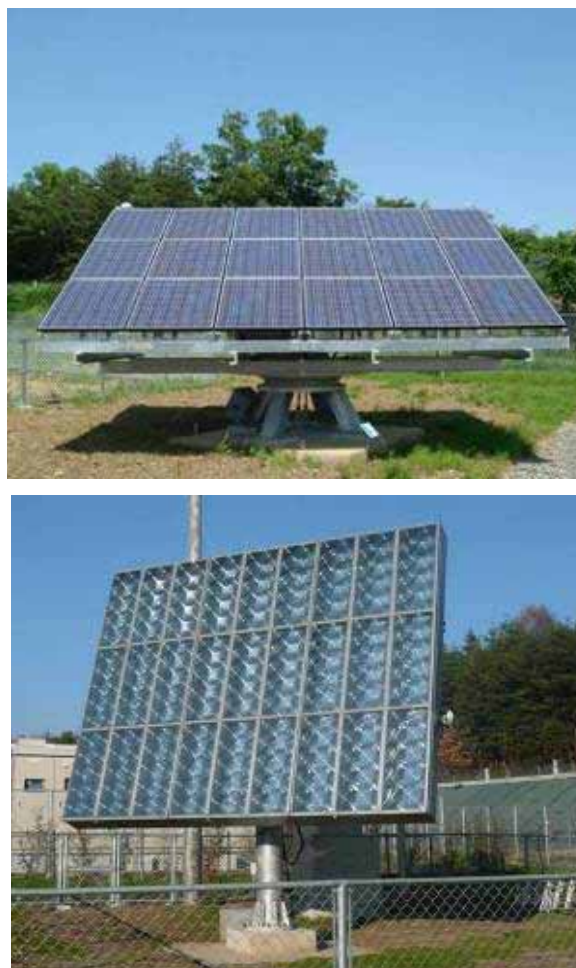
図 1.3.2-4 追尾システム（上：1 軸追尾、下：集光 2 軸追尾）
