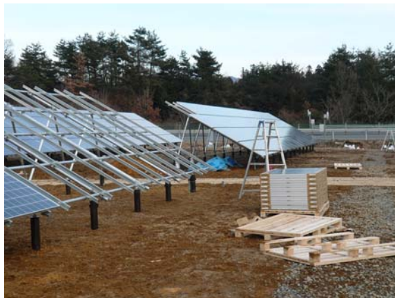
図 4.6.2-15 太陽電池モジュール取付
