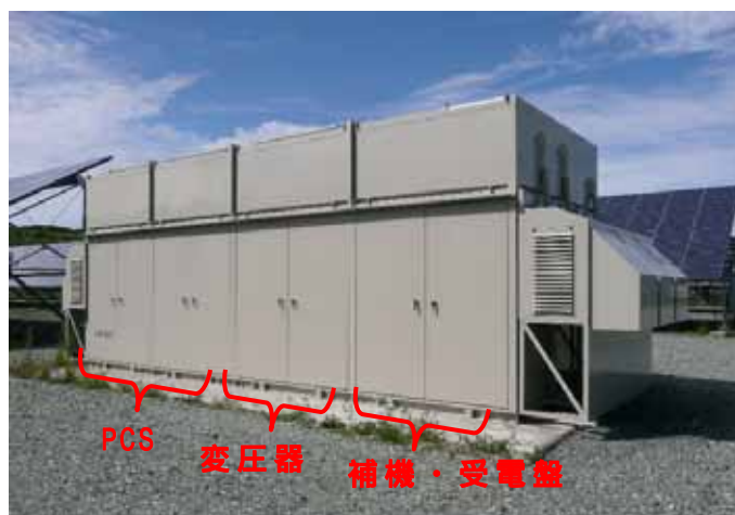
図 1.3.1-4 高圧出力タイプの PCS (6.6kV 定格出力 1,000kW)
