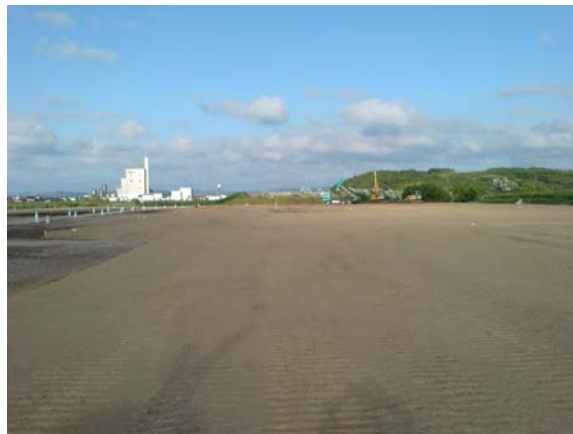
図 4.6.1-3 造成後（西側から撮影）
