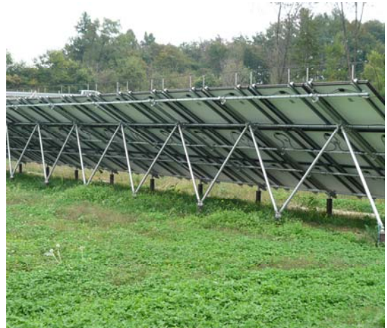
図 4.6.2-8 太陽電池アレイ用架台
