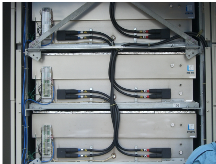
図 4.6.1-12 N A S 電池セル
