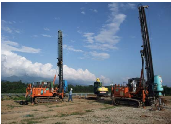
図 4.6.2-6 杭打ち施工状況
