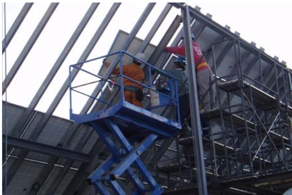
図 4.6.1-6 PV モジュール設置工事
