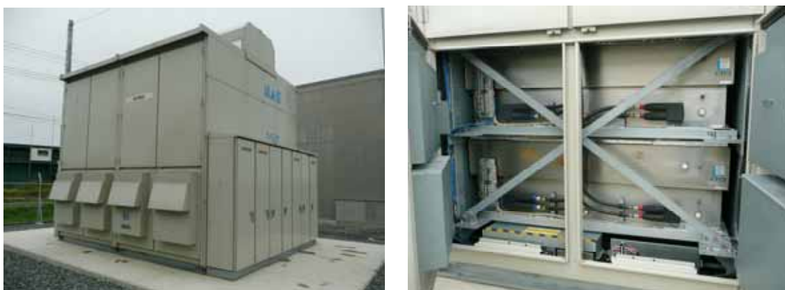
図 2.4-3 NAS 電池システム ( 外観および内部 )
