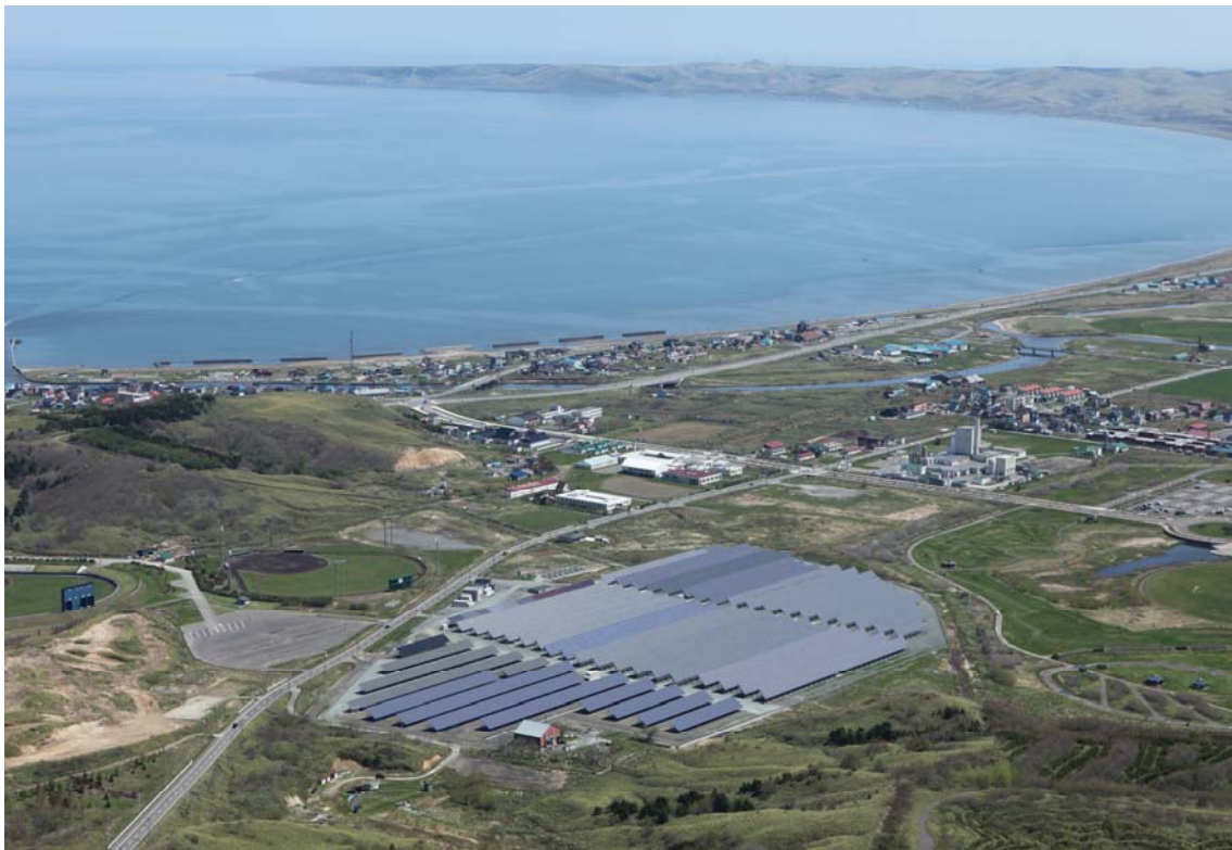
図 4.6.1-13 稚内サイト全景（南西側より撮影 写真上は宗谷岬）
