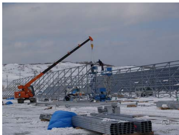
図 4.6.1-5 架台組立工事
