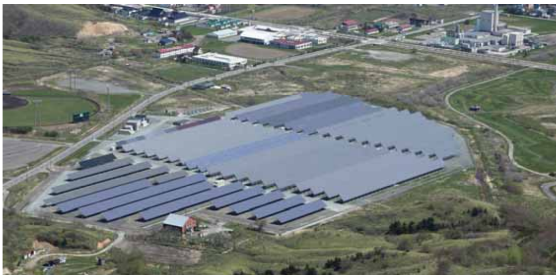
図 1.3.1-1 稚内サイトの全景
