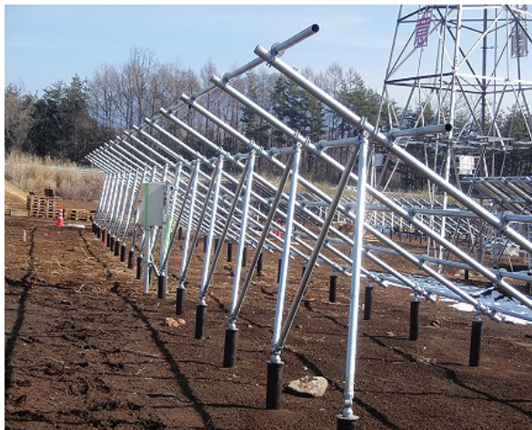
図 4.6.2-8 太陽電池アレイ用架台
