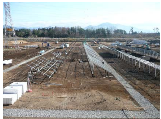
図 4.6.2-7 架台施工状況
