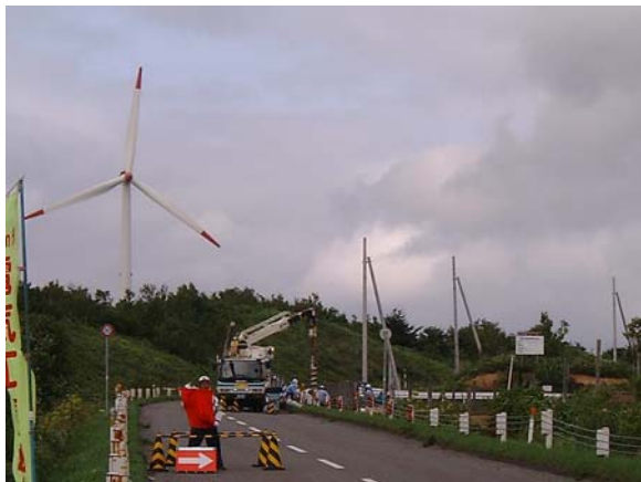
図 4.6.1-9 建柱作業状況
