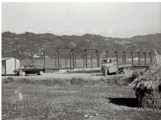
1963年(昭和38年)工場建設
