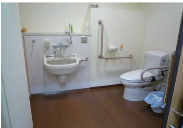
⑦ 車いす対応トイレ
