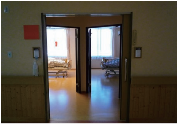
① 4床室を個室2つへ改修
