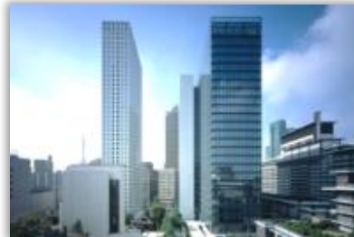
本社オフィスビル
