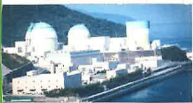
原子力発電所
