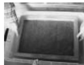
水そうから型枠を取り出し、上の枠をはずします。
