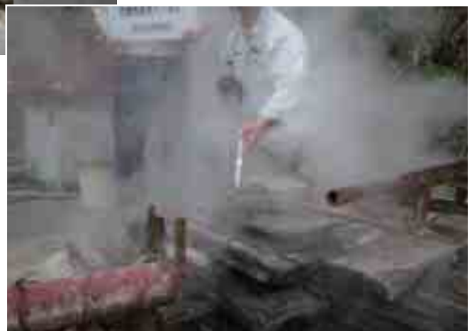
可燃性天然ガス濃度測定の様子
