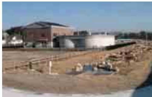
芳養漁港漁業集落排水処理場
