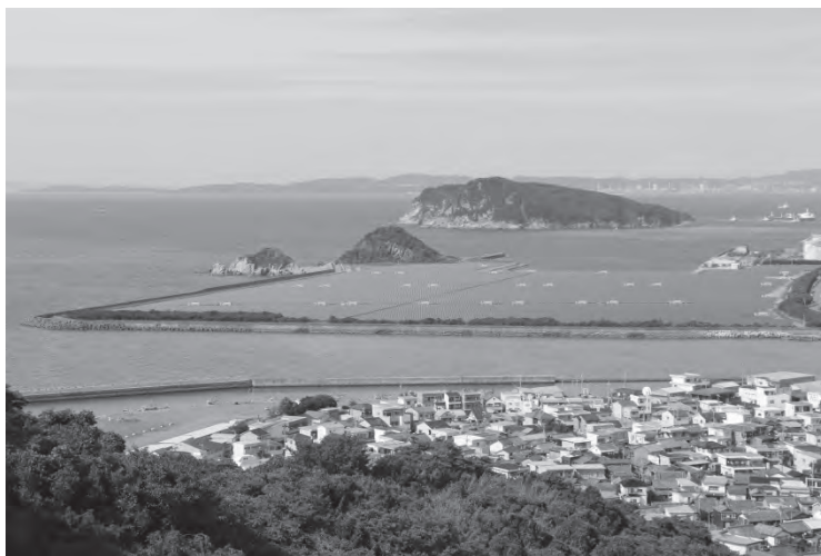
有田太陽光発電所
