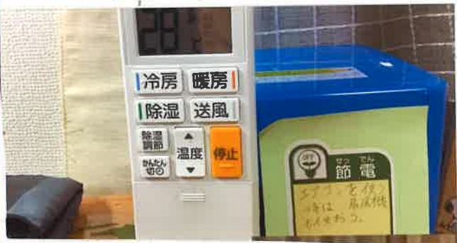
エアコンをつける時に見える所にある電源スイッチにエコシールを貼っているところ。
