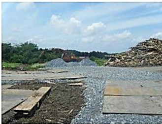
仮置場搬入路に敷設された砂利・鋼板 (宮城県松島町)
