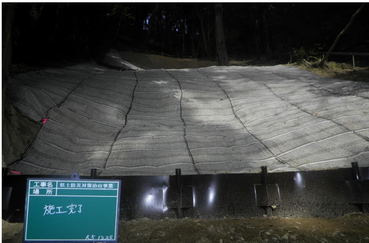
○施工後（森樹郎マット）
