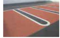
瓦骨材を特殊エマルジョンで吹付け固化させる薄層舗装材です。視認性が良い、滑り止め効果がある、耐摩耗性に優れる等の利点があります。
