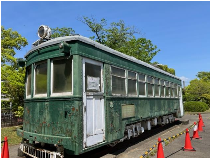
令和5年 撤去前
