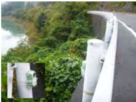
図 4.2.1 樺山ダム湖岸に設置している定点観測カメラ
