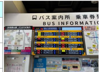
②JR和歌山駅構内に設置されているバスロケモニター
