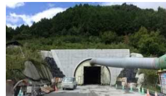
国道371号（新紀見トンネル）
