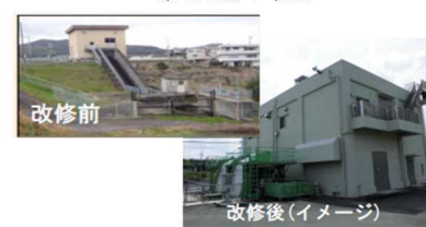
排水機の改修
