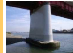
県道 高瀬古座停車場線 古座橋 (串本町)
