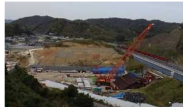
(仮称)和歌山南スマートIC工事
