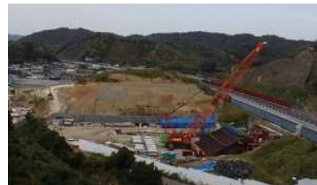
(仮称)和歌山南スマートIC工事
