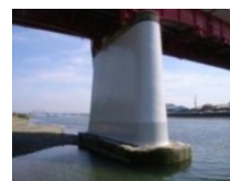
県道 高瀬古座停車場線 古座橋(串本町)
