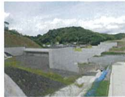
南紀田辺～すさみ間工事状況
