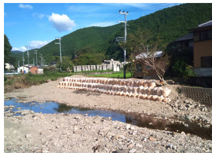
生馬川被災状況 (上富田町生馬地先)
