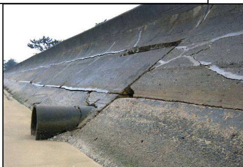
補強等の対象となる護岸 (例)
