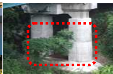
菖蒲橋 (橋脚巻立工)
