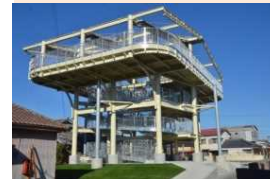
(津波避難タワー)
