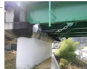
橋梁耐震化 落橋防止の設置
