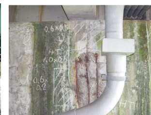
老朽化対策 コンクリートの剥離（橋脚）の補修
