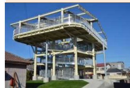
(津波避難タワー)
