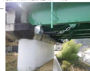
橋梁耐震化 落橋防止の設置
