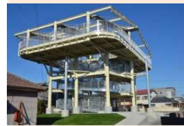
(津波避難タワー)
