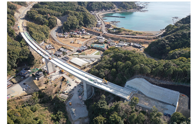
整備が進む「すさみ串本道路」
