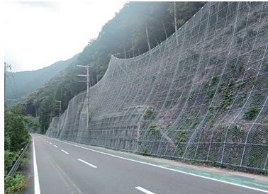
国道169号法面对策
